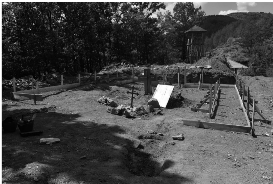
Слика 5. Површина предвиђена за изградњу након истраживања, документација Завичајног музеја Жупе
